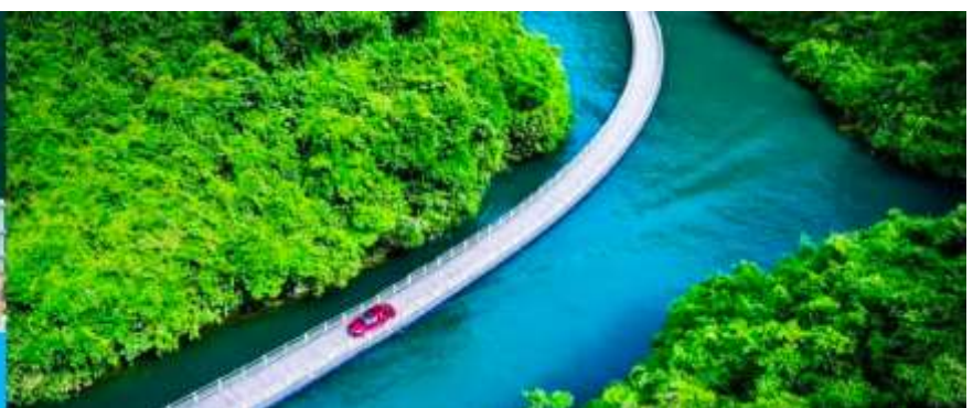
บ่อร์รถผ่านชมถนนลอยน้ำด่านลิ่งโก
