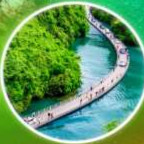
สะพานระบียงผิน
